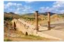
สะพานเซเวอร์วัน
